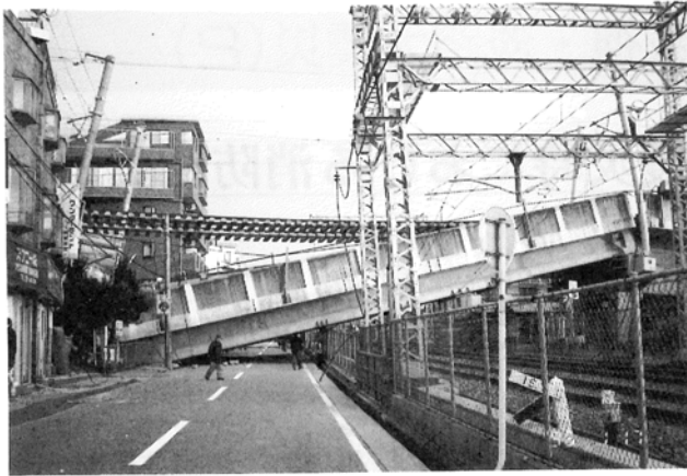
写真1 落下した新幹線の高架
