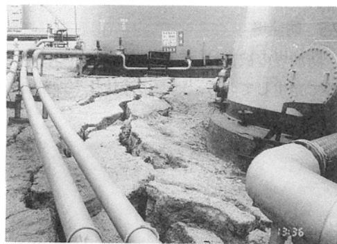
写真 5 タンク基礎近傍の地盤状況
