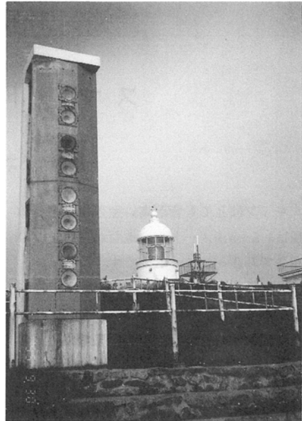
写真3 北海道襟裳岬の霧笛発生装置
