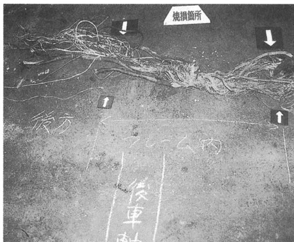
写真2 ワイヤーハーネスの焼損状況
