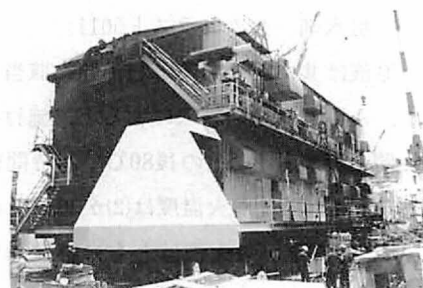
写真1 出火したモジュール
