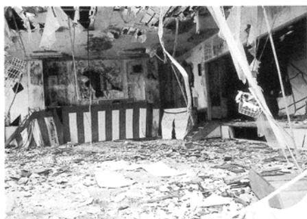
写真1 横殴り噴石による幼稚園ホールの惨状 「もしここに園児がいたら…！」火口から600m
