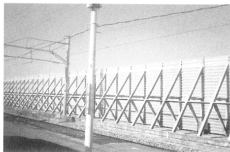
写真2 鉄道防風・防雪柵 (JR北陸本線市振駅)
