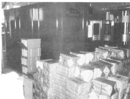
写真 1 ボイラー室内の状況
