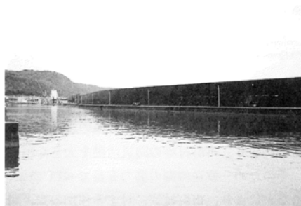
高知県室戸漁港の防波堤
