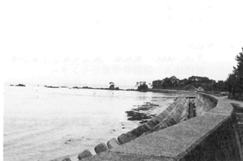
写真1 宮城県気仙沼市付近の海岸と防潮堤 (旧明戸集落付近)
