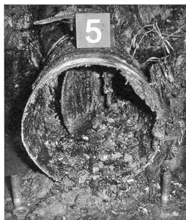
写真10 5番テーブルの排気ダクト内部
