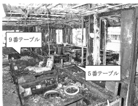
写真1 客室の焼損状況
