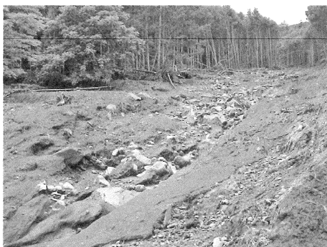
図3 西支流の土石流流下状況（図1 b地点）
