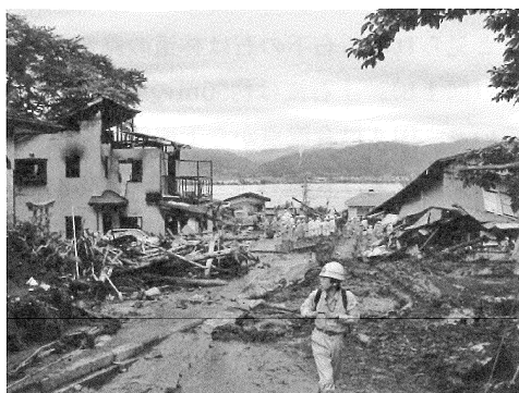
図6 湊三丁目集落の被災状況（図1 d地点）
