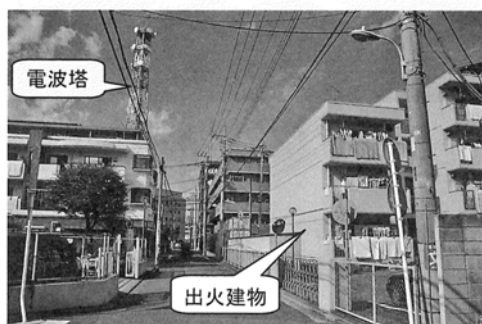
写真6 現場周囲の状況
