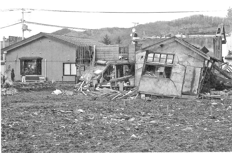
写真7 建物構造や竜巻の進行経路により隣接した建物同士で異なった被害
