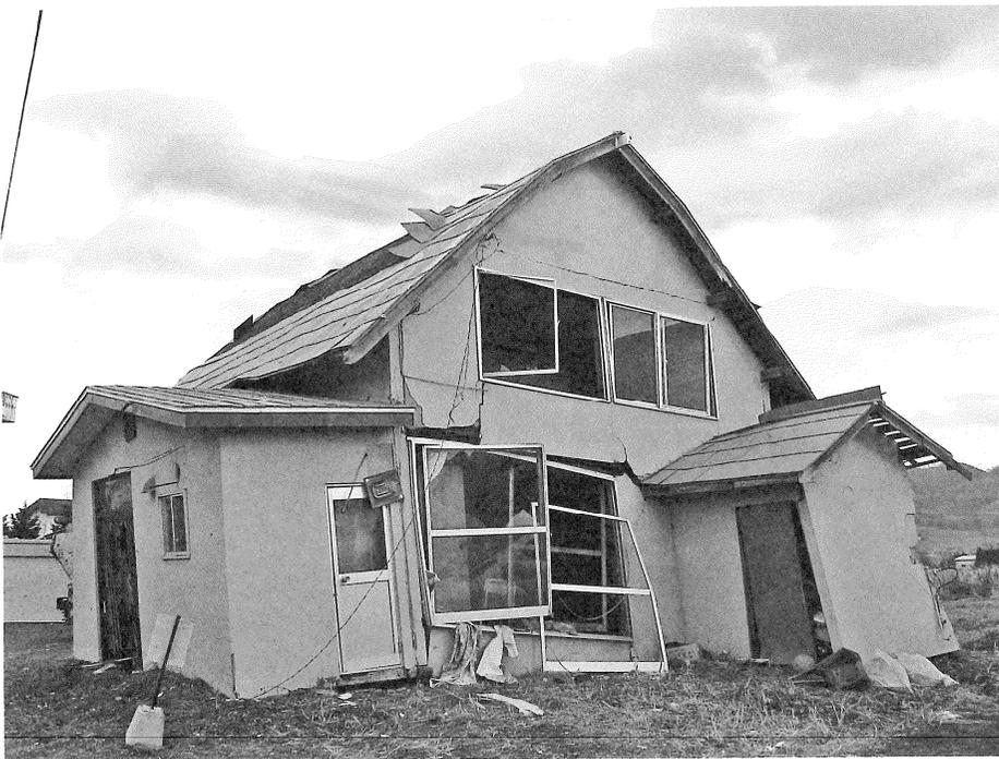
写真8 竜巻により写真右側から大きな力を受けて被災したと見られる建物
