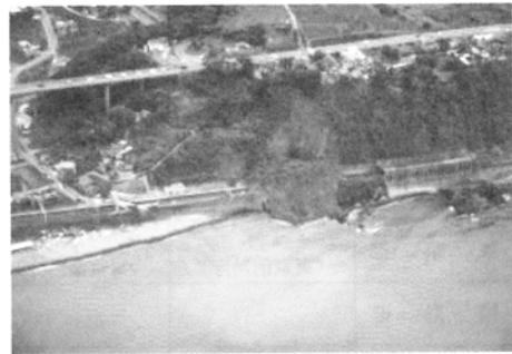
大規模な土砂崩れ (東京消防庁航空隊撮影)
