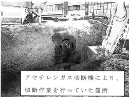
タンクの地上引き上げ時に、重機により開けられた穴(鏡面側)
