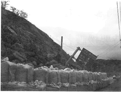
寸断された道路
