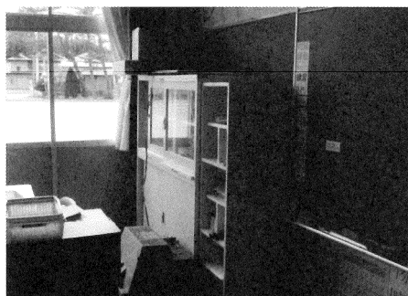
棚の上から落下した教室のテレビ（奥州市内）
