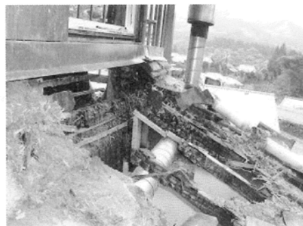
写真 3 屋根面の状況
