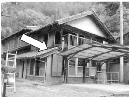
写真 1 出火建物の全景
