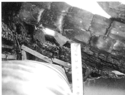
写真 2 煙突及び天井裏の状況
