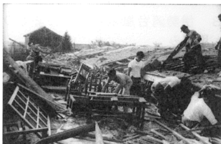
土岐市下石小学校2階建て校舎は、軒をつらねて倒壊【土岐市下石町】
