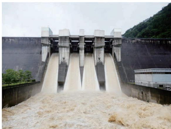
写真-1 防災操作中の日吉ダム（独）水資源機構提供）
