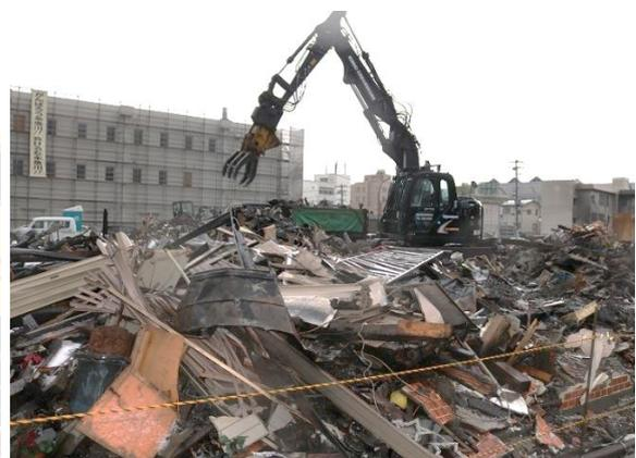
写真6 大型重機による積み込み
