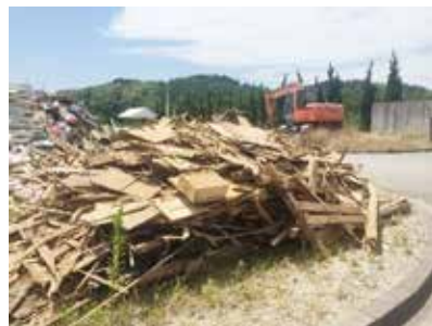
建設解体廃棄物
