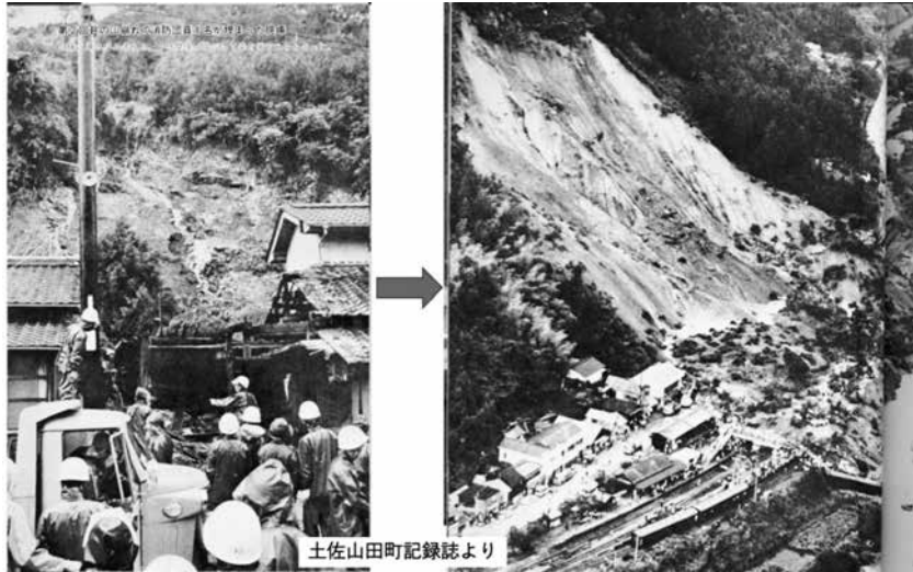
図3 高知県土佐山田町繁藤で発生した地すべり災害の様子（土佐山田町による記録誌 2) から）
