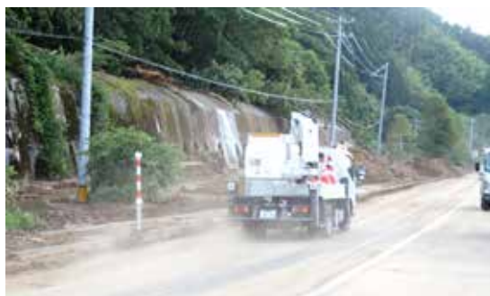
図4 山からの水が流れ続ける中の復旧作業 （関川村 - 小岩井地区の国道113）
