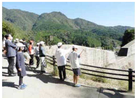
図10 砂防堰堤の見学
