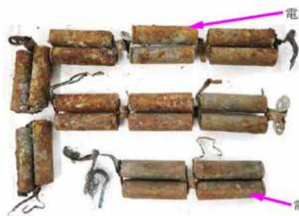
【写真7 焼損した電池セル】
