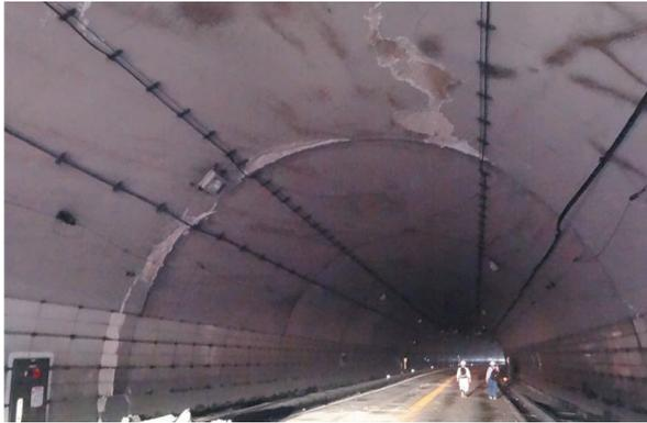
図-14 4月16日の地震後の俵山トンネルの被害
