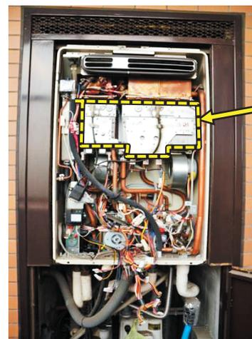
焼損した制御基板
