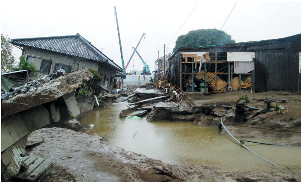
平成27年9月関東・東北豪雨により被災した常総市の様子 (2015年9月17日撮影)
