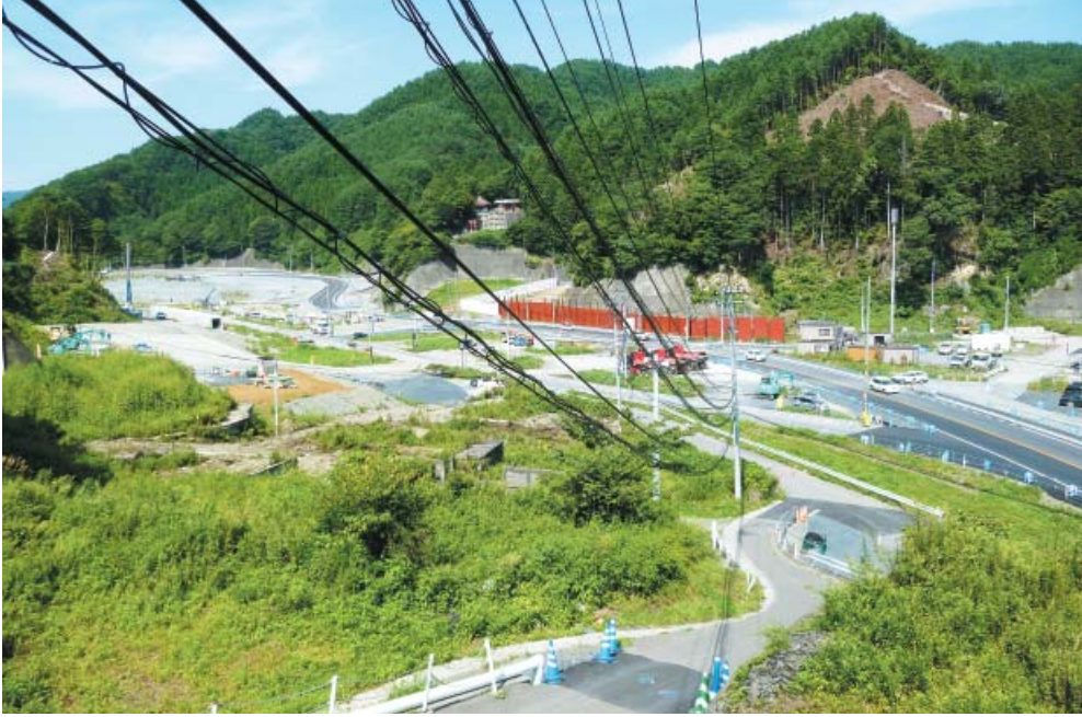
岩手県釜石市両石地区の復興工事の様子 (2015年9月3日撮影)
