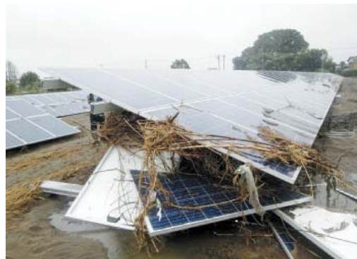
図7 現場付近の太陽光発電機器の被害
