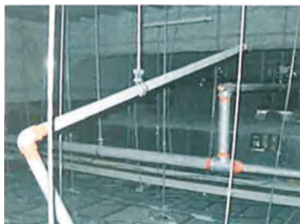
写真1：横引き配管の損傷事例（平成23年（2011年）東北地方太平洋沖地震（東日本大震災）、震度6強地域（気象庁発表））
