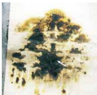
実験 B の床面（コンパネ）の焼き状況
