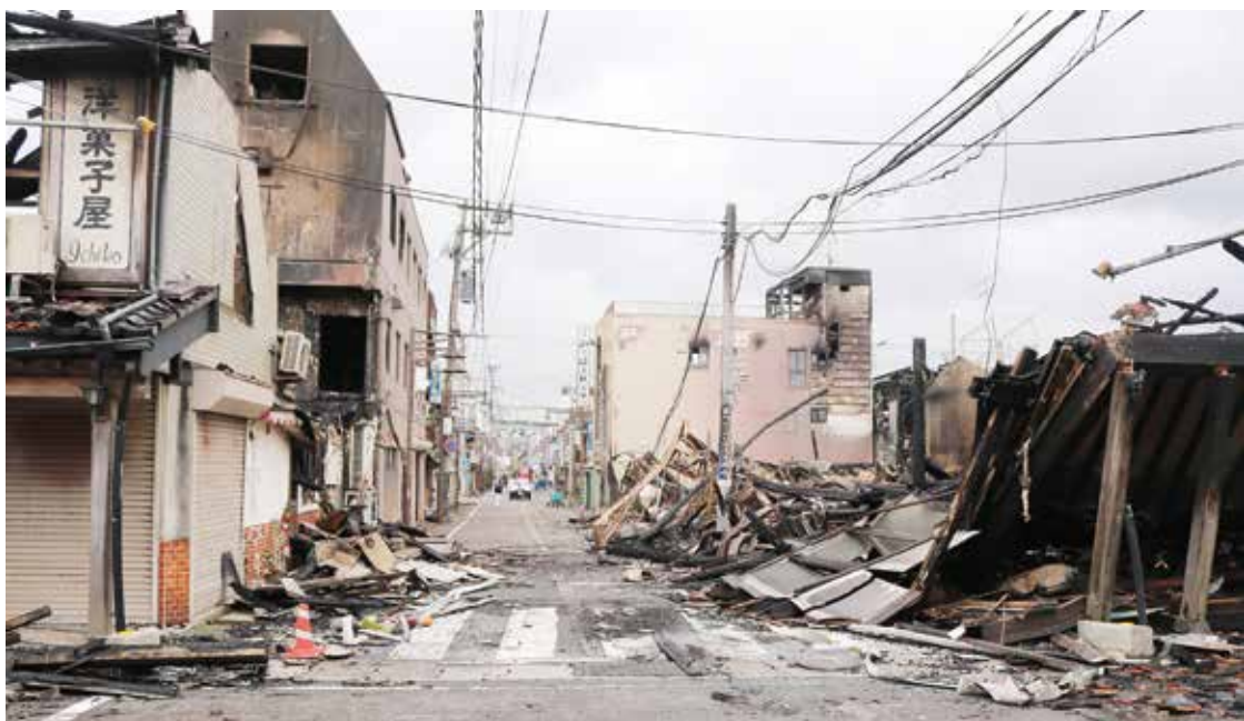
被災後の市街地の様子（本町十字路交差点から南側を見る） 2016年12月23日撮影（写真提供：新潟県糸魚川市）
