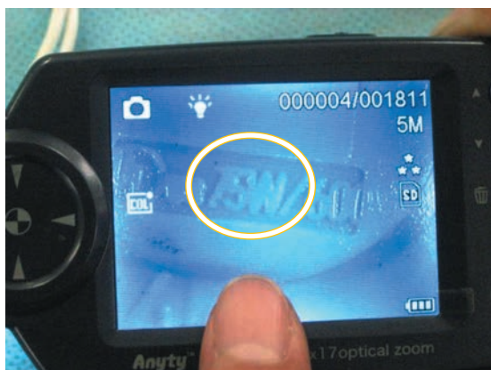
写真16 焼けているソケット
