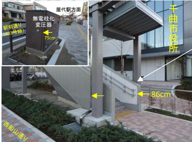
写真3 千曲市役所前の連絡橋における浸水痕跡
