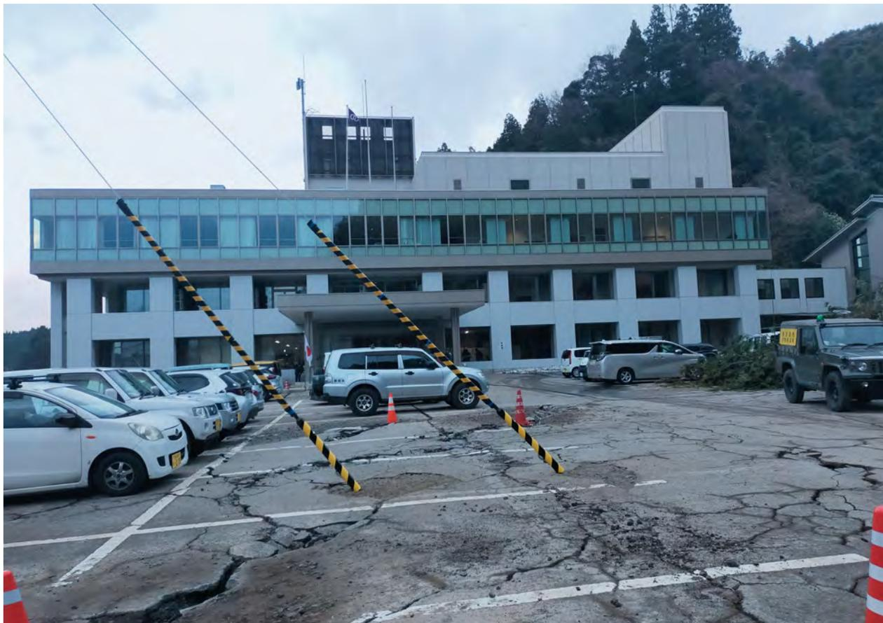
石川県穴水町（役場）：地震により多数の亀裂が走った駐車場（2024年1月5日撮影）
