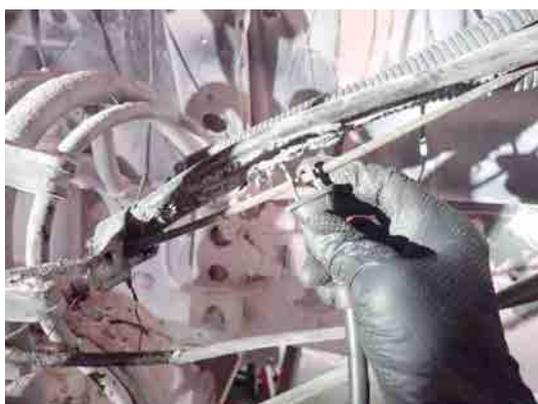
写真8 漏電立証時の状況（出火点）
