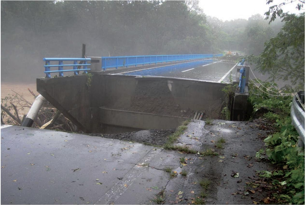
ヌビナイ橋：氾濫により背後が洗掘され、町の8割に水を運ぶ送水管も損壊
