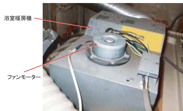
写真2 小屋裏側の状況
