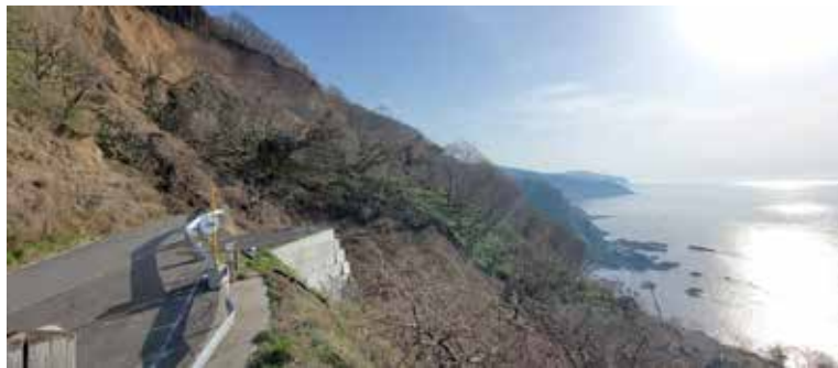
写真3 地すべりによって崩落した道路（輪島市ゾウゾウ鼻付近：2024年4月7日青木撮影） 地すべりの移動体の下方に崩落した道路（路面、電柱、ガードレール）が見える
