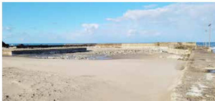
写真2 隆起によって干出した漁港（輪島市黒島漁港：2024年2月16日 青木撮影）
