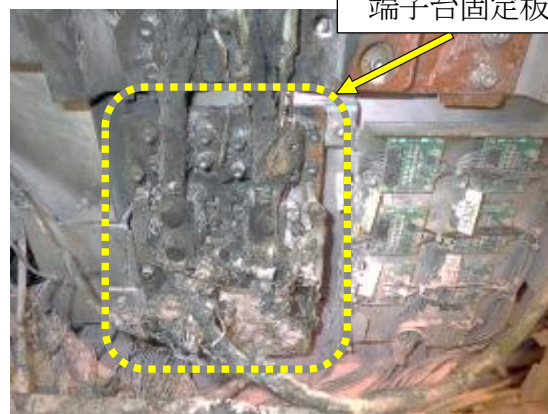
【写真17 端子台固定板の状況】
