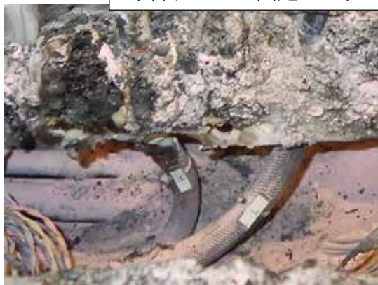
【写真15 下部ケーブル固定ブロック下方の状況】
