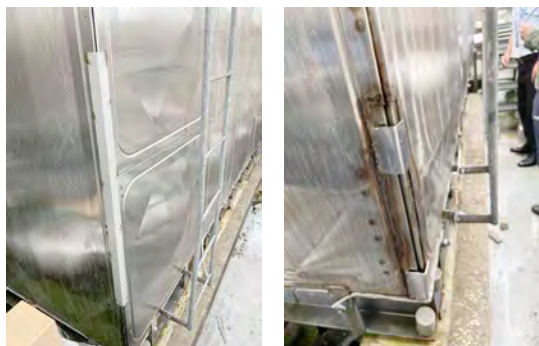
図4 ステンレスパネル水槽の応急補修 1)
