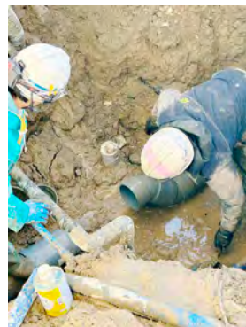
(2) 掘削工事状況 2)
