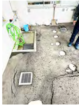
図11 地盤沈下により使えなくなったトイレ 2)
