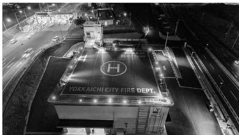
北部分署の屋上ヘリポート（夜間でも離発着可能）
