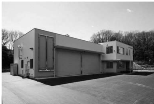
南部分署の外観
