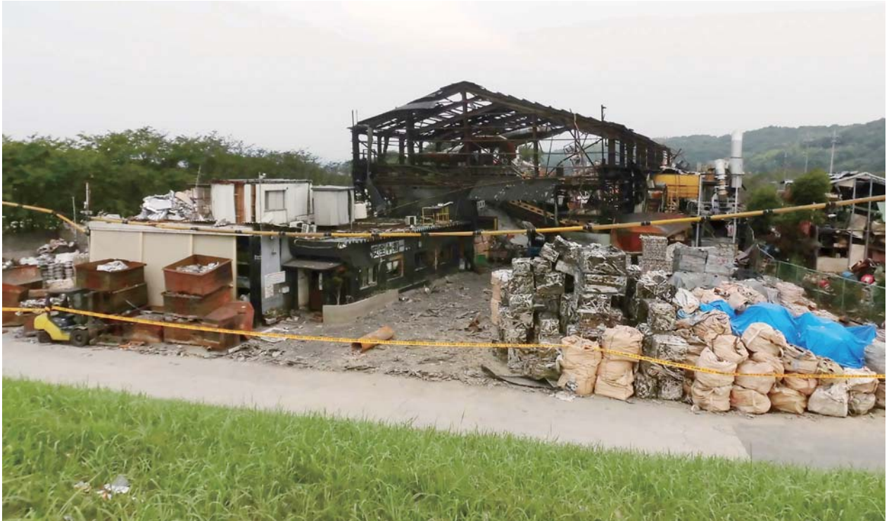
岡山県総社市 浸水が原因と見られる爆発現場 (2018年 7 月18日撮影)
