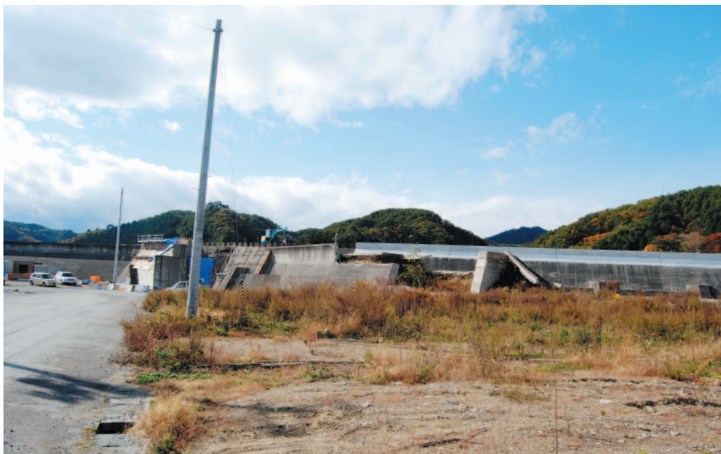
岩手県宮古市田老町補修工事中の防潮堤 (2014年10月28日撮影)
