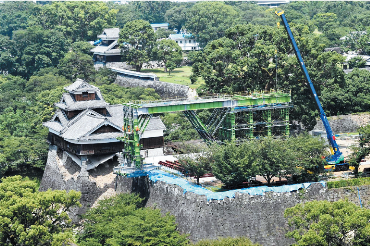
熊本城飯田丸五階櫓倒壊防止工事 2016年7月21日撮影（写真提供：熊本城総合事務所）
