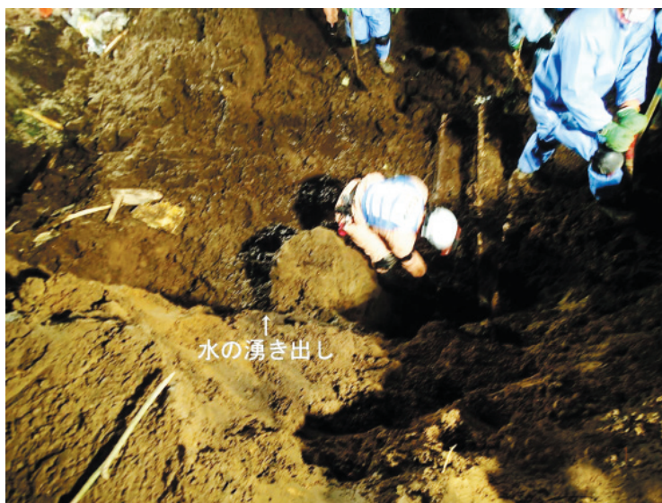
図6 掘削地点からの水の湧き出し状況
