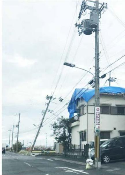
写真7 折損・倒壊した電柱（左：大阪府泉南市、産経新聞社産経フォト<sup>9)</sup>、右：大阪府泉南市、著者撮影）
