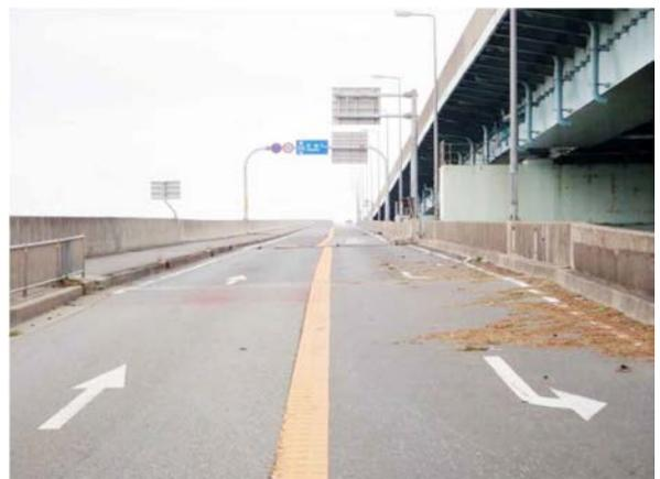
図7 台船の衝突により橋桁が動いた甲子園浜の県道573号線の被災状況
