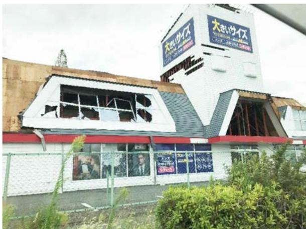
写真5 店舗のガラス破損、外装材剥離（大阪府貝塚市、著者撮影）
