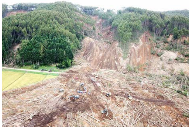
図6 幌内地区第一現場の状況
