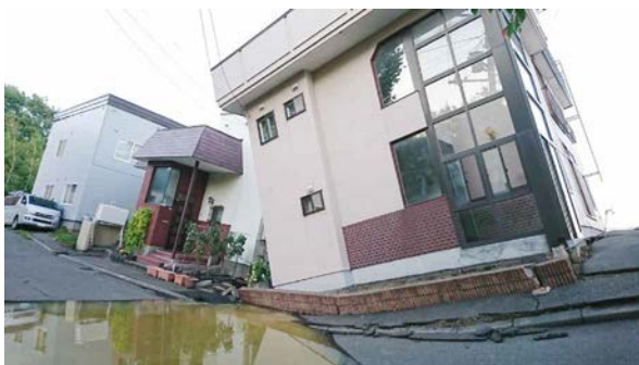
写真-4 被災地の状況（地点 c）
