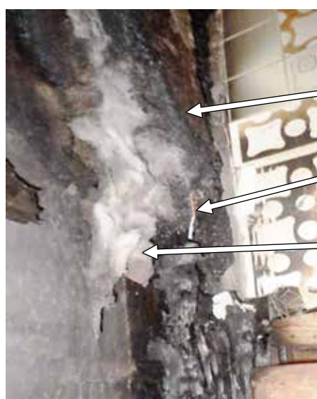
【写真7】1階トイレ壁内
