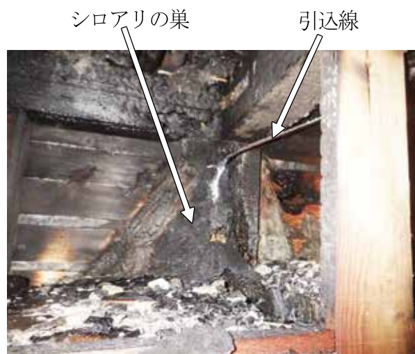
【写真6】1階天井裏
