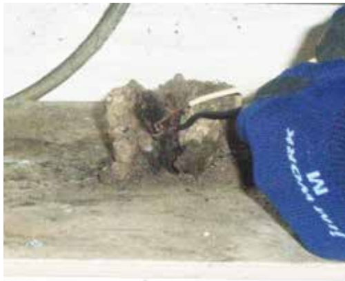
【写真19】実験2の状況
