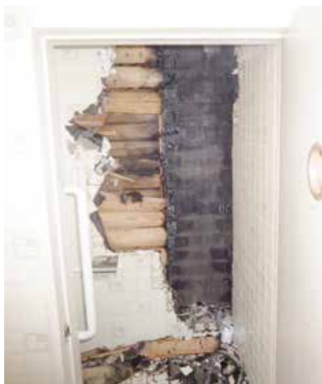
【写真5】1階トイレ
