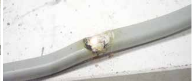
【写真18】実験1の状況
