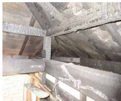
【写真4】2階天井裏
