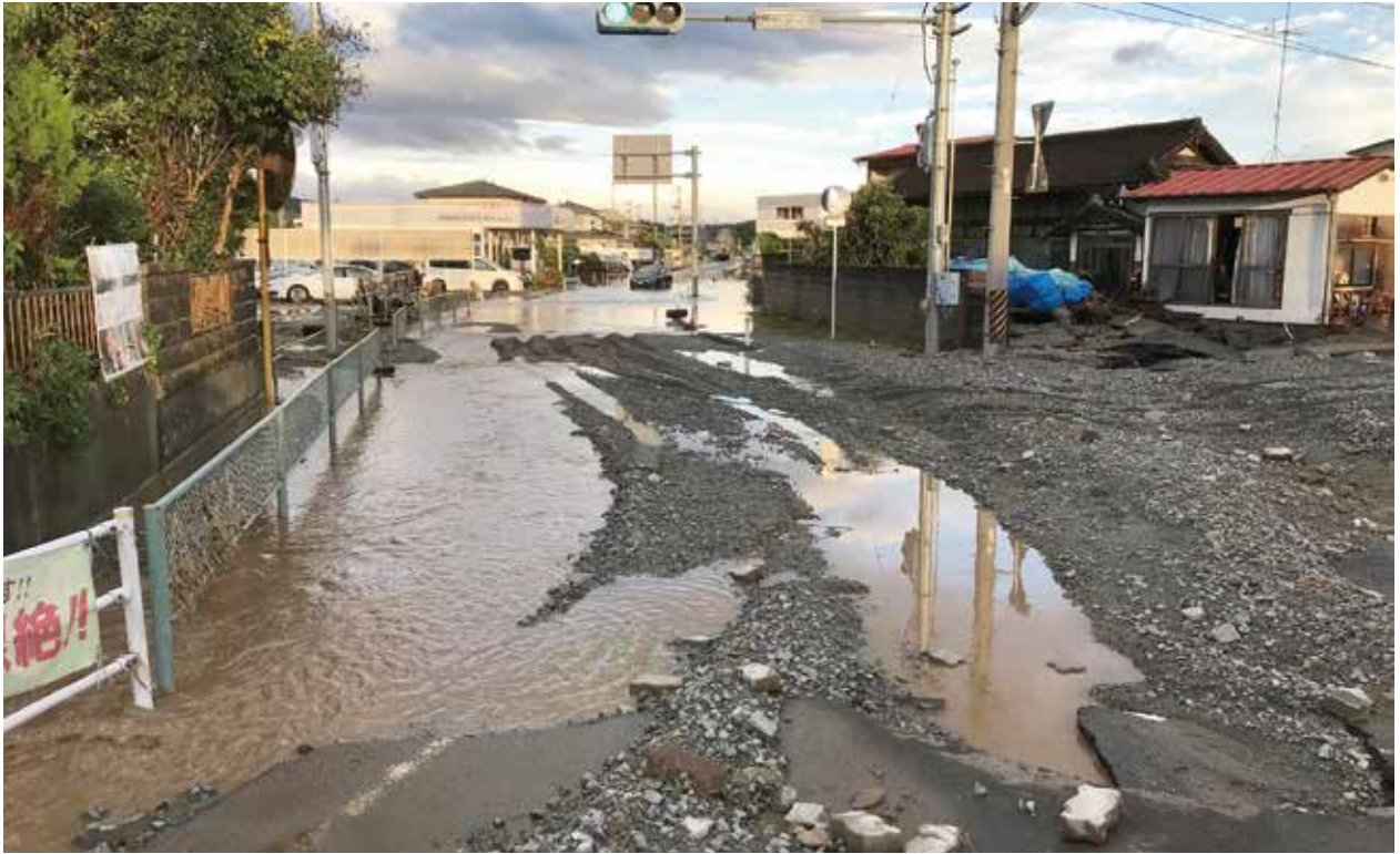
金山地区被災の様子 写真提供：宮城県丸森町役場
