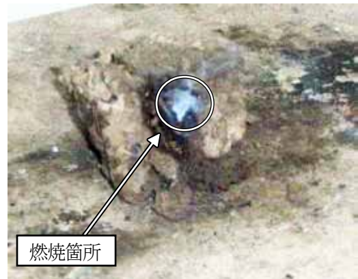
【写真20】実験2の状況
