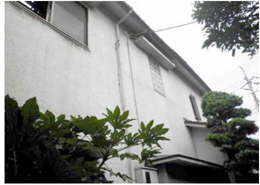
写真2 建物外周部（北西側）
