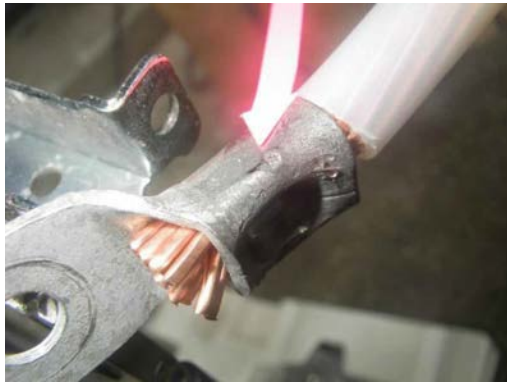
写真24 実験2回目丸型圧着端子の状況
