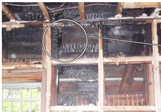
写真8 内壁を剥がした状況
