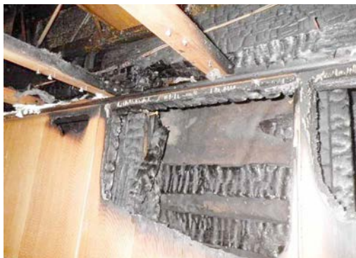
写真7 応接間北西側内壁の状況
