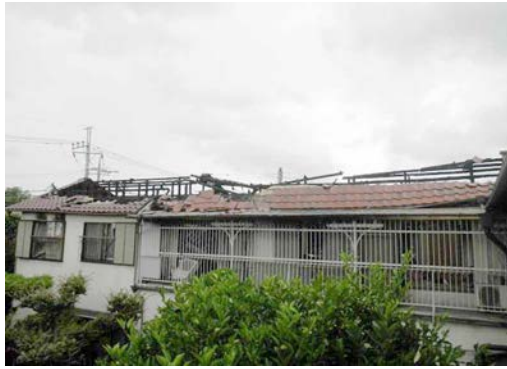
写真1 建物外周部（南東側）
