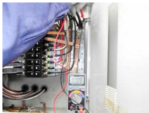
写真12 黒色配線とヒンジの導通確認
