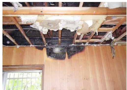
写真6 応接間北西側内壁の状況
