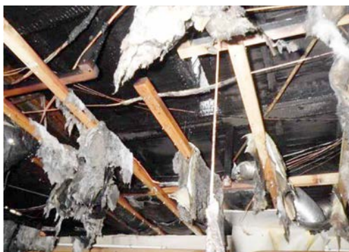
写真5 天井及び天井裏の状況
