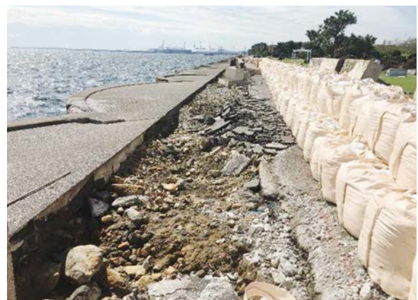
図-8 本牧横浜港シンボルタワー周辺における護岸の倒壊
