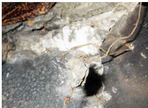
写真14 ワイヤーラスの状況
