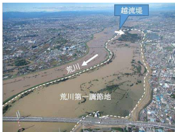
(b) 荒川第一調節池
