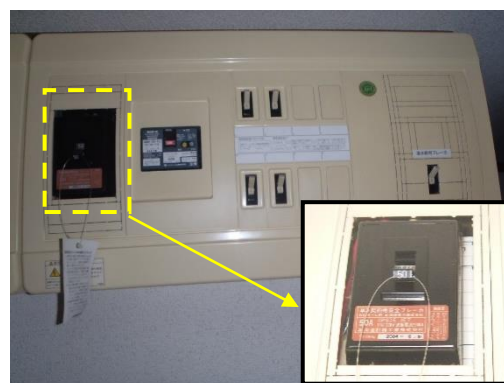
写真13 2階西側にある住戸の分電盤の状況
