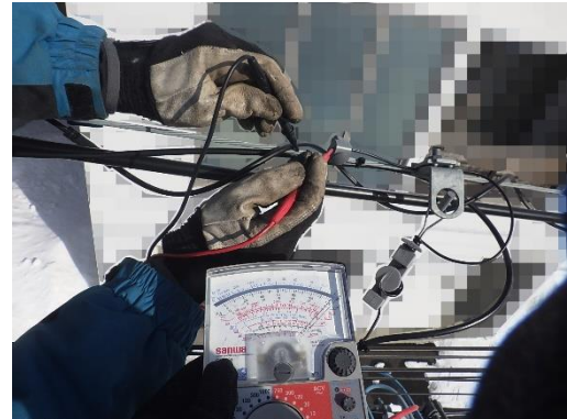
写真20 A線とB線の導通試験の状況
