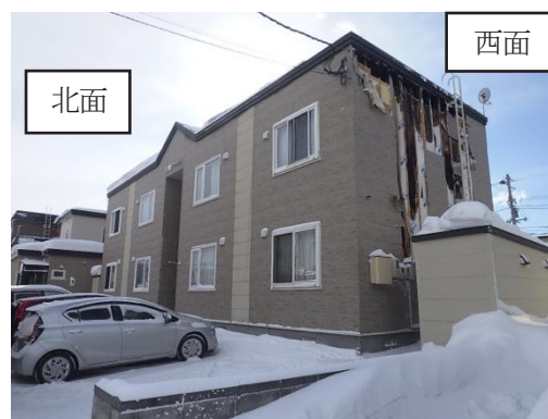
写真1 建物外観の状況
