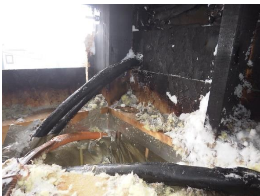
写真11 小屋裏内の引込線貫通部の状況
