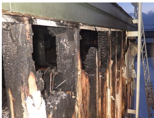
写真2 建物外観西面の状況
