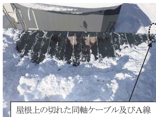
写真5 トタン屋根西端中央の状況
