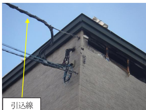
写真3 建物外観北西角の状況
