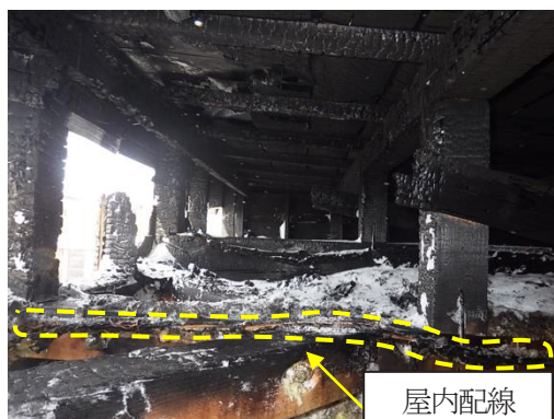
写真9 南側から見た小屋裏内西側の状況
