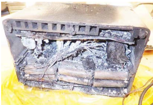
写真12 ポータブル電源上部の状況
