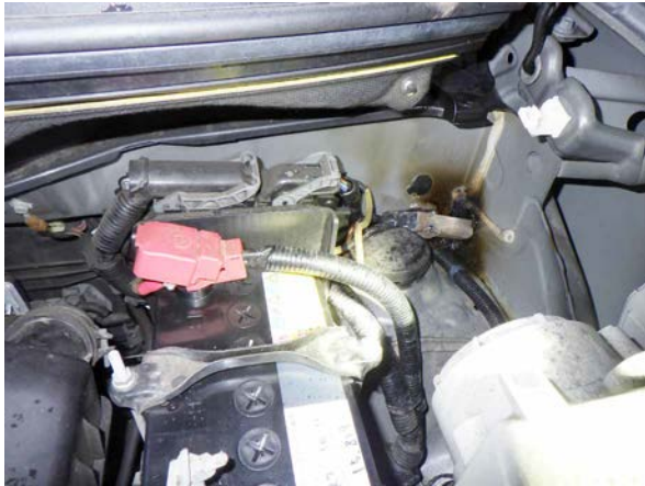
写真6 エンジンルーム内バッテリー周辺の状況
