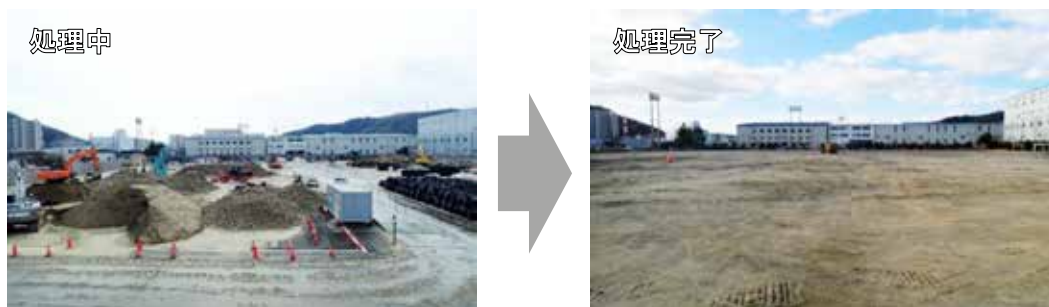
図6-1 二次仮置場（坂町北新地運動公園）
