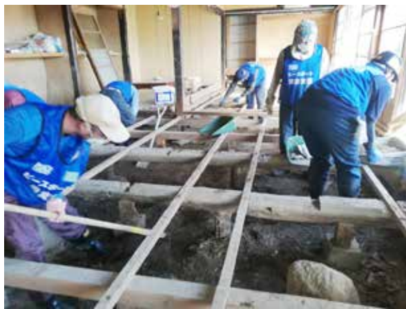
写真2 床下の清掃活動
